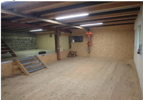
Lager / Zuschnitt im OG
